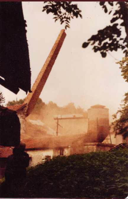
Les cheminées de l'usine Alif
