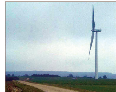
Parc éolien de Blercourt
